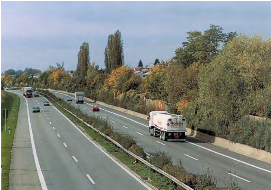
In die Umgebung integrierte Lärmschutzwand
